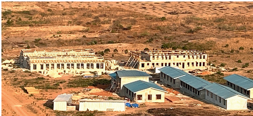
Links hinten Küche-Mensa-Aula - Mitte Verwaltungsgebäude - rechts hinten Schlafsäle - rechts vorne 4 Klassenräume
