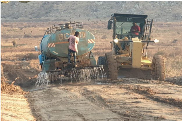
Erschließungsarbeiten auf dem Gelände
