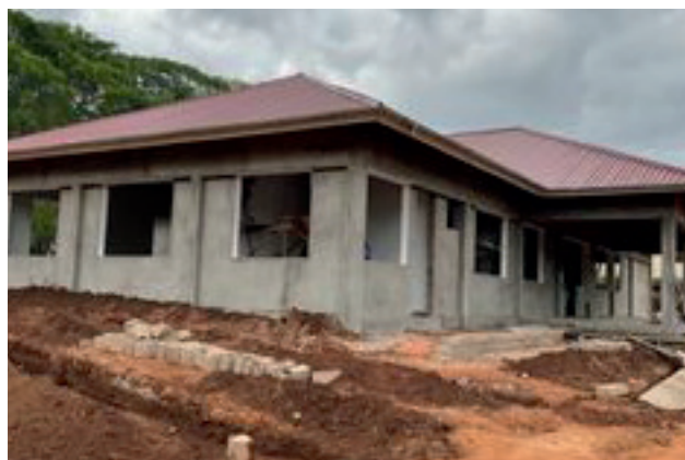
Neubau Schulungsräume Berufsbildungszentrum
