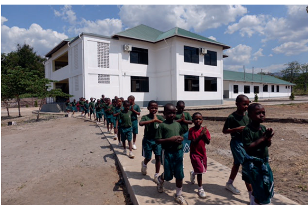
Großprojekt Küche, Speisesaal und Aula Pre & Primary School 2020/2021
