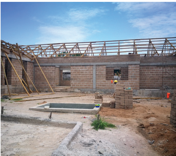
Baustelle Küche, Speisesaal und Aula
