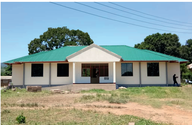
Administrationsgebäude Pre & Primary School mit Lehrerzimmer, Staff Room, Verwaltung und Lager
